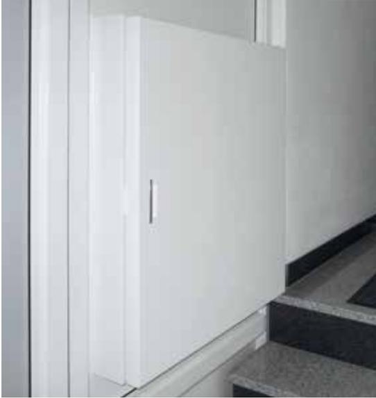
Die Anlage ist komplett thermisch getrennt und besitzt zur Innenseite eine 30mm isolierende Verkleidung.
