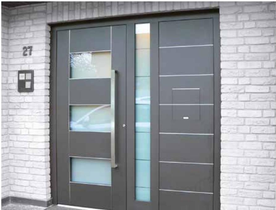
Axialbox im Seitenteil mit teileingelassenen Edelstahl Lisenen der Haustürfüllung angepasst
